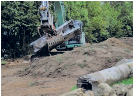
Der letzte Betonmast in Etzwilen liegt am Boden, eben wird der Sockel aus dem Boden gehoben.
