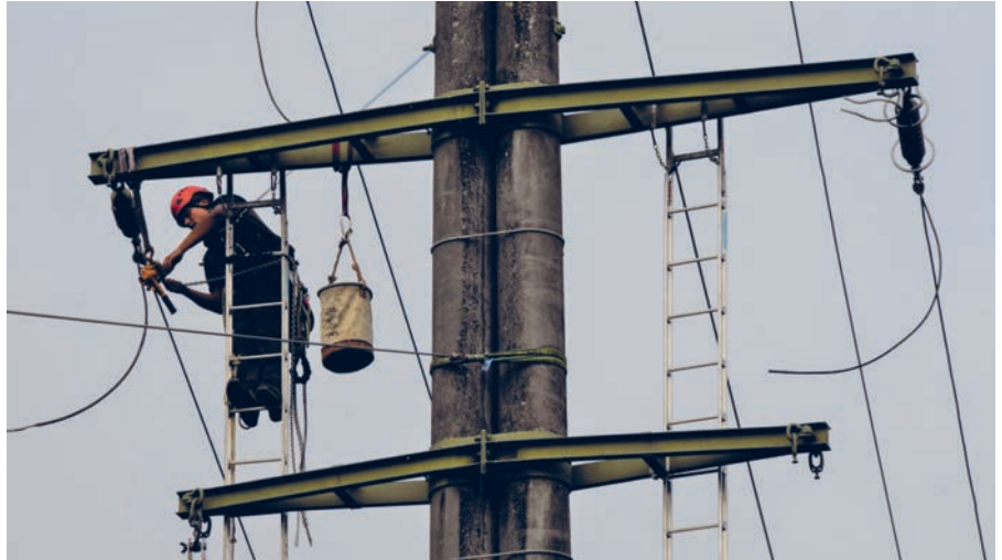
Die letzte Stunde für die Hochspannungsleitung hat geschlagen: Entfernen der Leitungsseile, später Fällen der Masten. Bilder: Johannes von Arx
