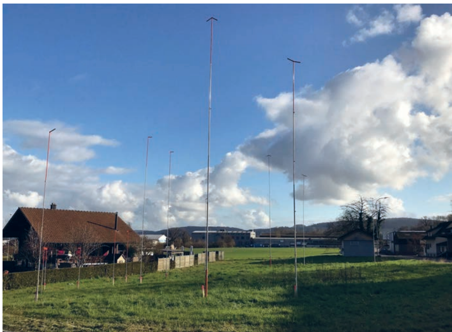
Während der Auflagefrist zeigten die Bauvisiere auf der Schööfferwis das Ausmass des Projektes.
