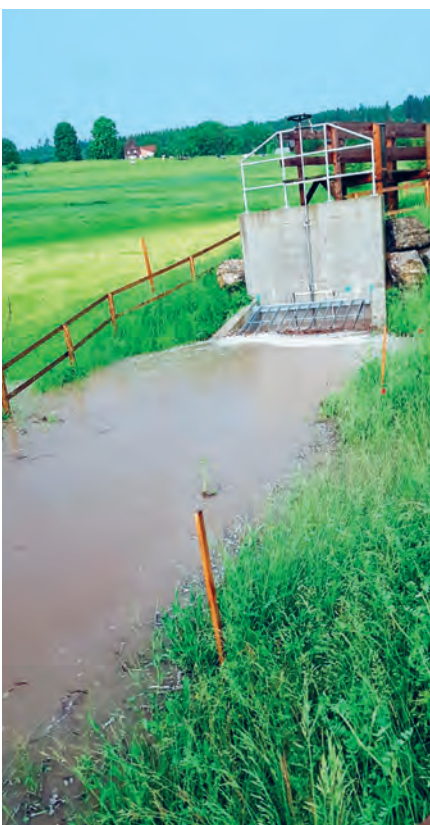
Hochwasserschutz mit Einlaufbauwerk Eichenbühl.
