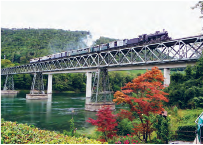
Auf der historischen Rheinbrücke, 6. September 2020.
