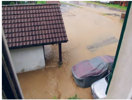
Überflutung Schulhaus Rheinklingen.
