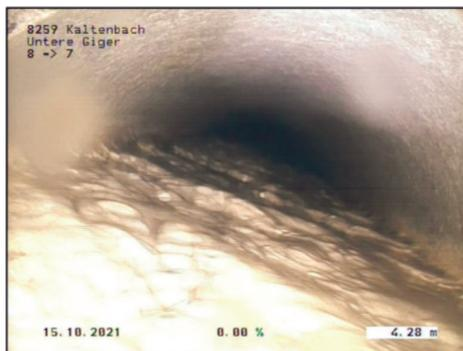
Das Projekt sieht vor, die Entwässerungsleitung in der Strasse «Unterer Giger» durch eine neue Kunststoffleitung PP 400 mm auf einer Länge von ca. 400 m zu ersetzen. Parallel dazu werden auch vier neue Kontrollschächte erstellt. Um das Sicker- und Hangwasser vom Strassenkörper fern zu halten, wird neben der Entwässerungsleitung eine Sickerleitung mit der Dimension von 160 mm mitverlegt. Das Oberflächenwasser der Strasse wird über Schlammsammler gefasst und in die Entwässerungsleitung geführt.
