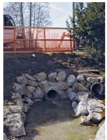
Auf dem Bild – von der Nordseite des Bahndamms aufgenommen – ist rechts die ursprüngliche Röhre zu erkennen. Links die neu erstellte Entlastungsröhre.
