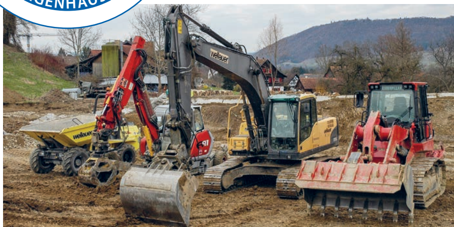
Grossbaustelle Hochwasserschutz 2. Bauetappe mit Rückhaltebecken Eichenbühl in Kaltenbach (Foto: Annemarie Brunner).
